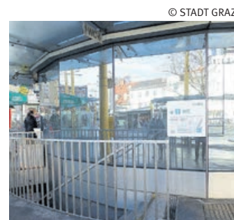
© STADT GRAZ Gesperrt. Das öffentliche WC am Jakominiplatz wird saniert.
