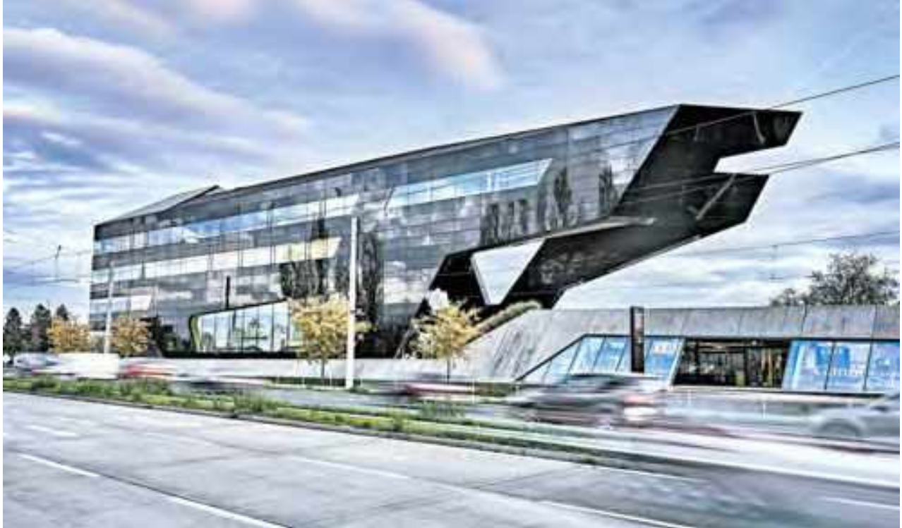
Architektonische Kraft und wirtschaftliche Flexibilität vereint in einer Stadt. Im Bild das „MPoG Pachleitner Headquarter“.
