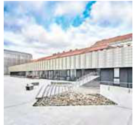
Auffallender Baldachin aus gold- färbigem, gestanztem Aluminium- blech. Einst war hier eine Wagen- remise untergebracht. (2014)
