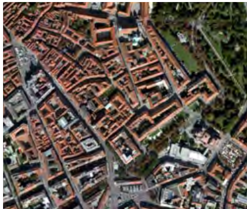
Abbildung 16: Die Klasse „Gebäude“ im Innenstadtbereich (MUICK 2011)
