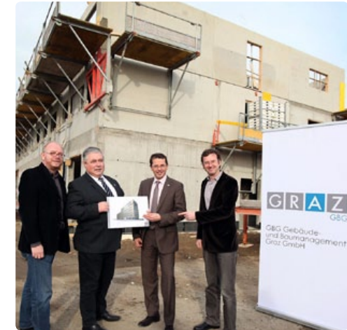
Baustellenbesichtigung. GBG-GF Mag. Günter Hirner (2. v. re.) mit Prokurist Bernd Weiss (2. v. li.) und den Projektleitern Ing. Rainer Plösch und Ing. Martin Eisenberger (re.).
